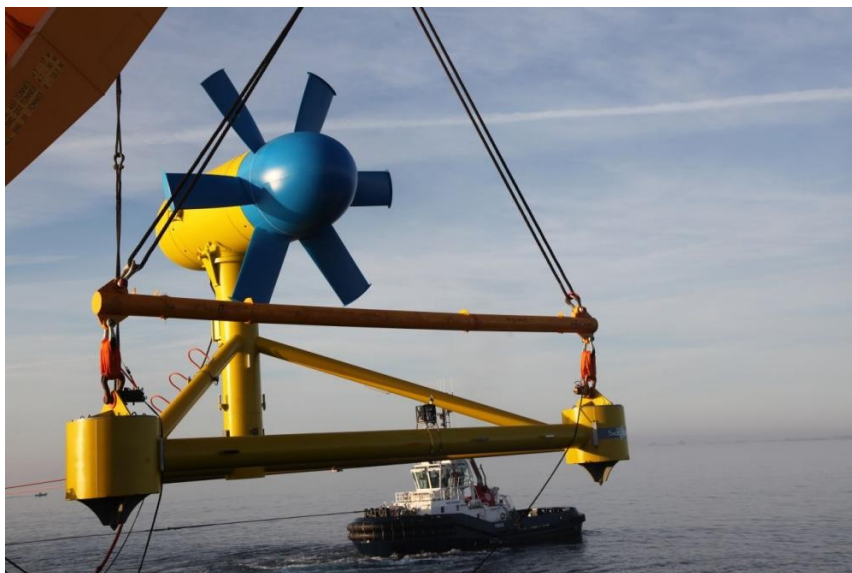
Mise à l'eau de l'Hydrolienne Sabella au large d'Ouessant
